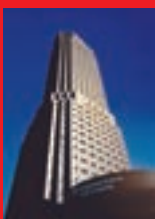
セルリアンタワー 東急ホテル
